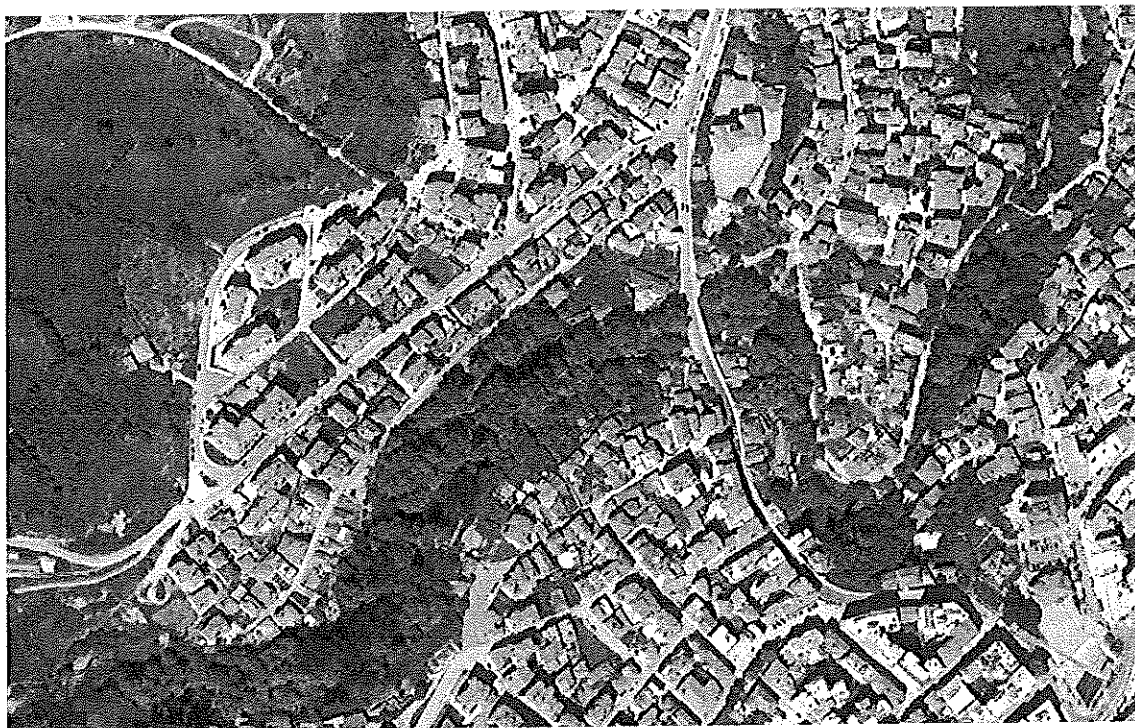
Φωτ. 1 Θέση του κτίσματος στον οικιστικό ιστό
