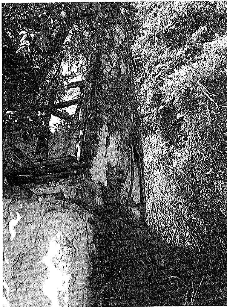
Φωτ. 5 Βόρεια όψη
