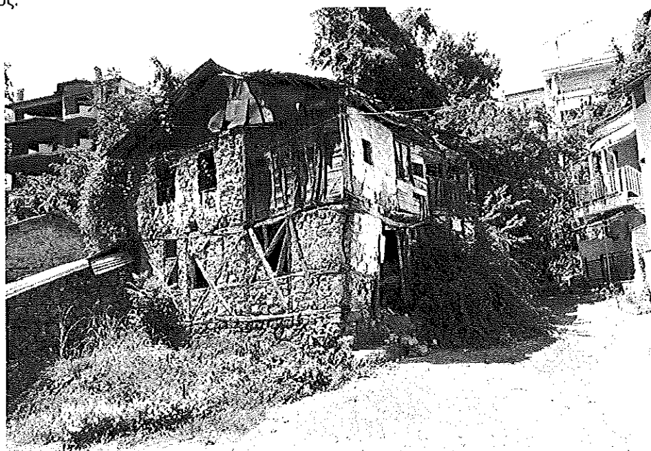
Φωτ. 2 Νοτιοανατολική όψη
